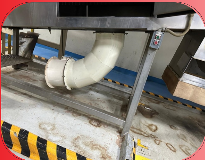
Codo instalado de 50 cms por 90
