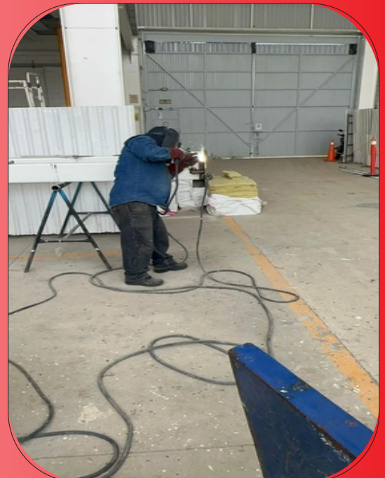
Fabricación de columnas para nave
