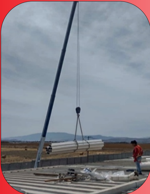
Montaje de tubería de PVC aislada
