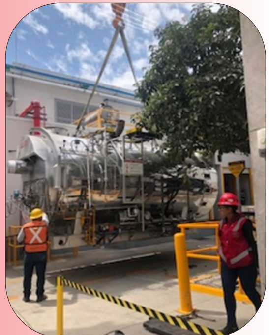
Desmontaje de caldera
