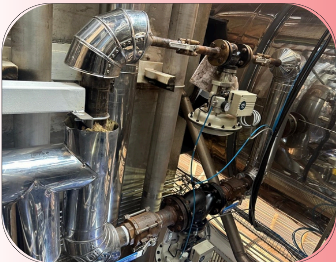
Instalación de válvulas de control de vapor
