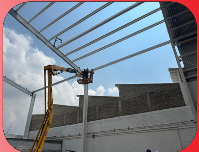
Montaje de estructura para nave
