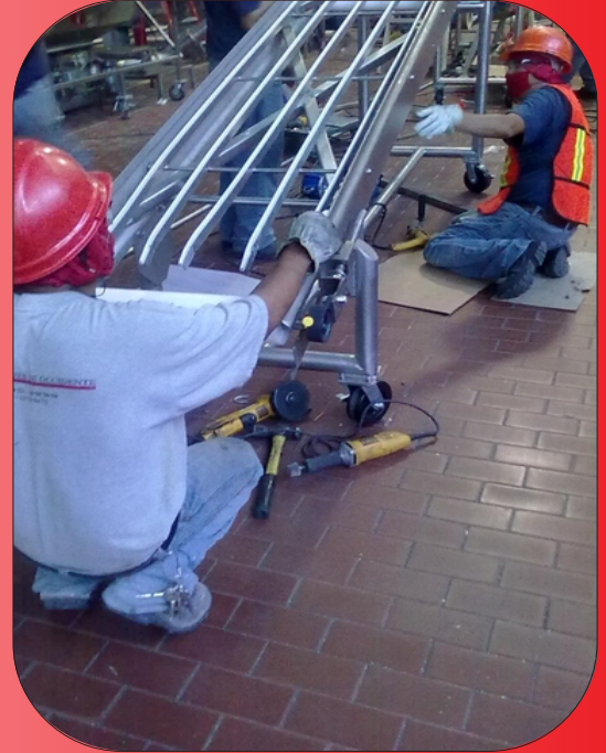
Transportador armado con perfiles laterales y guías de solera con separadores de tubo inoxidable
