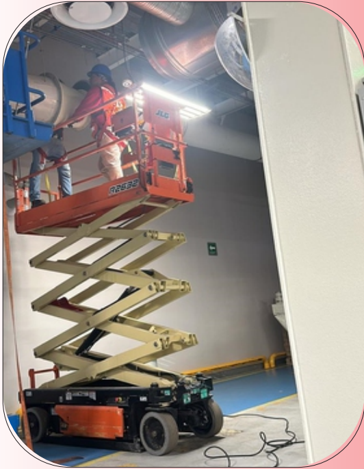
Instalación de ductos colector de polvo
