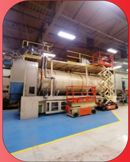
Reubicación de equipos
