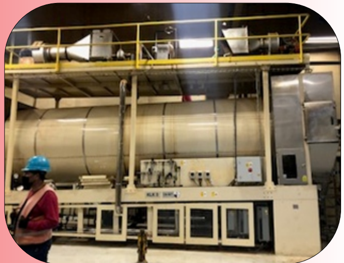
Reubicación de equipos
