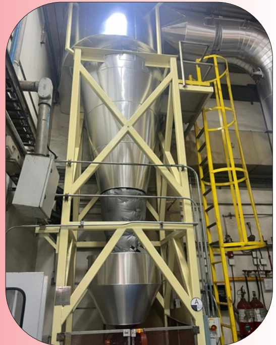
Instalación de ciclón
