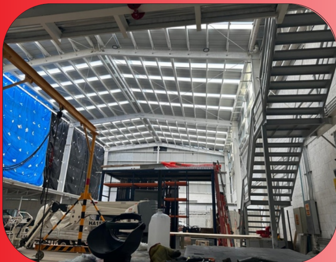
Estructura de nave
